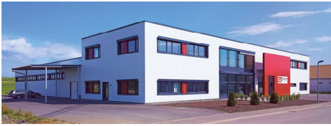
Im Dauchinger Gewerbegebiet Riesenburg befindet sich das hochmoderne Werk III der Schwenninger Firma Carl Valentin. Foto: Privat
